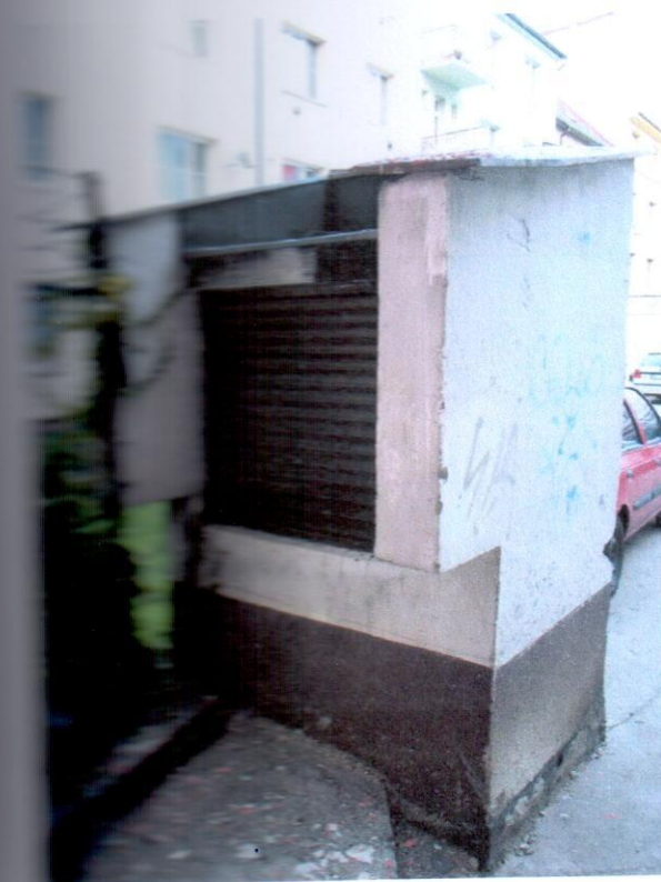
Príklady na nadzemnú časť malých vetracích šachiet nad chodbou a druhou technickou miestnosťou. Narušená hydroizolácia, najmä v styku vodorovnej izolácie stropu a zvislej izolácie stien.
