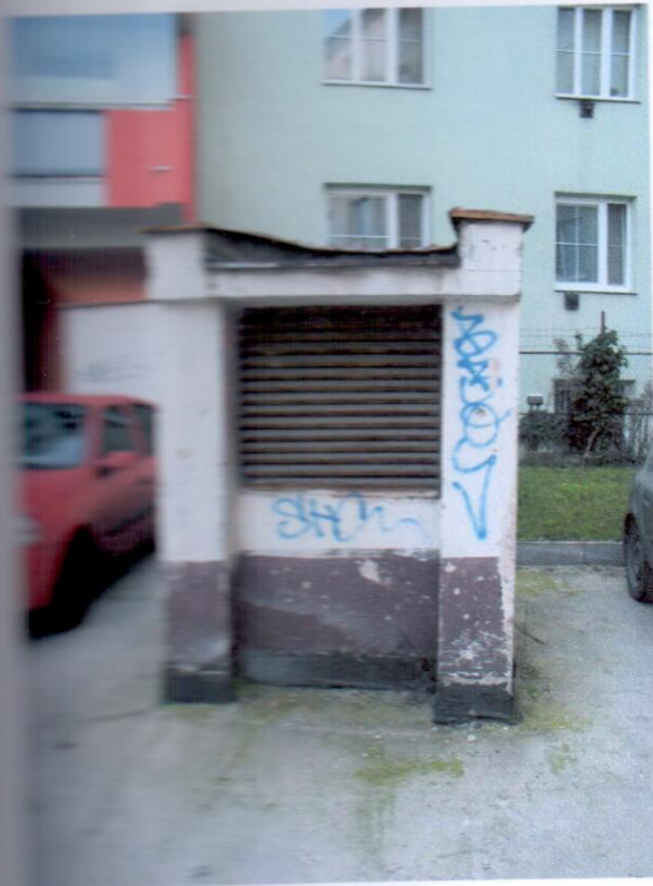
Príklady na nadzemnú časť malej vetracej šachty nad technickou miestnosťou.
