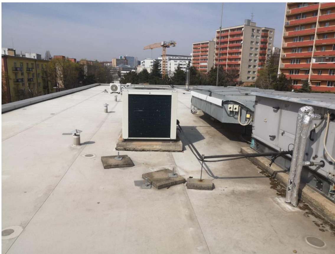
Príloha č. 1 - Náhľad existujúceho stavu strechy a vstupu do budovy
