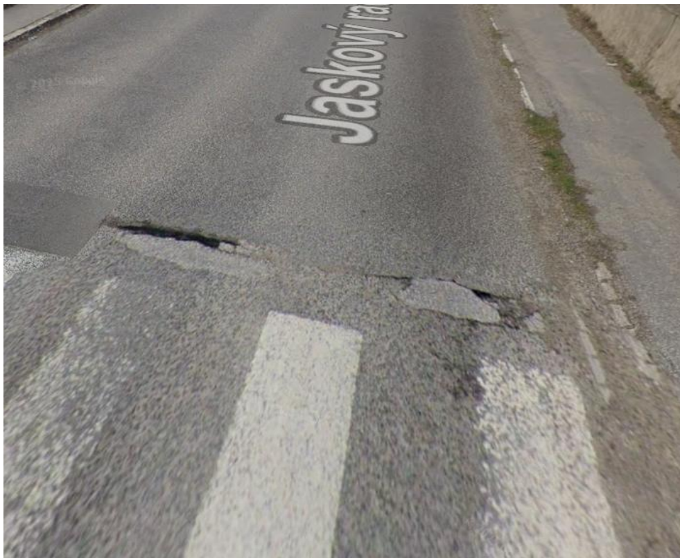
14. Jaskový rad – príprava podkladu k osadeniu spomaľovacích vankúšov
