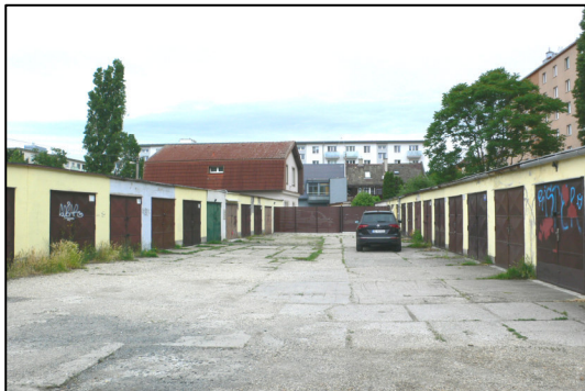
vnútroblok radových garáží
