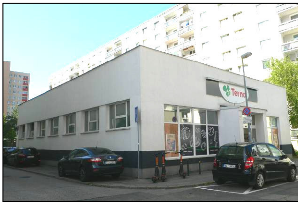
budova potravín TERNO s.č.10938 na parc.č.11518/2
