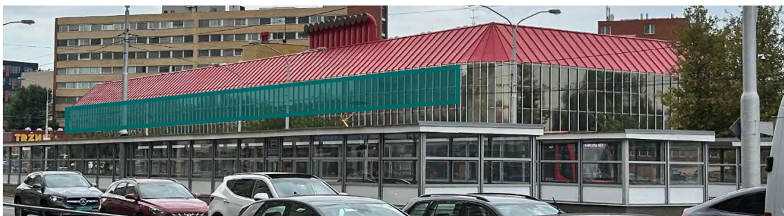
Obrázok 67 - Ľahký obvodový plášť s vyznačením zasklenia s integrovanou fotovoltikou
