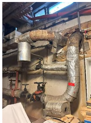
Obrázok 6– Prívod teplovodu do objektu
