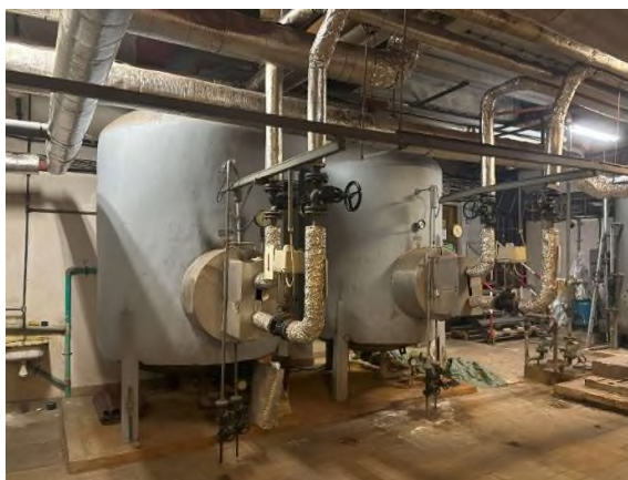
Obrázok 7– Zásobníkové ohrievače na 1.PP
