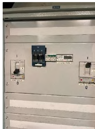
Obrázok 41 – Meradlo elektrickej energie
