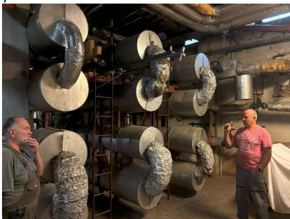
Obrázok 5– Protiprúdové výmenníky tepla
