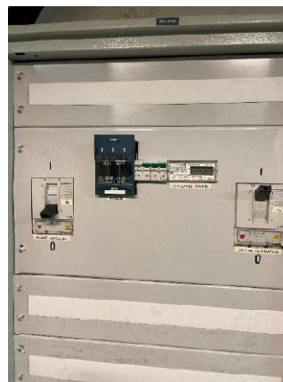
Obrázok 41 – Meradlo elektrickej energie
