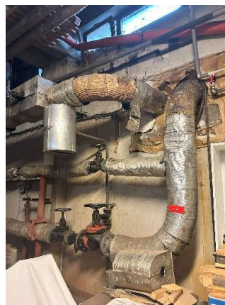
Obrázok 6– Prívod teplovodu do objektu
