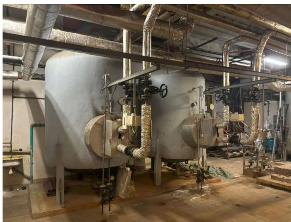
Obrázok 7 – Zásobníkové ohrievače na 1.PP
