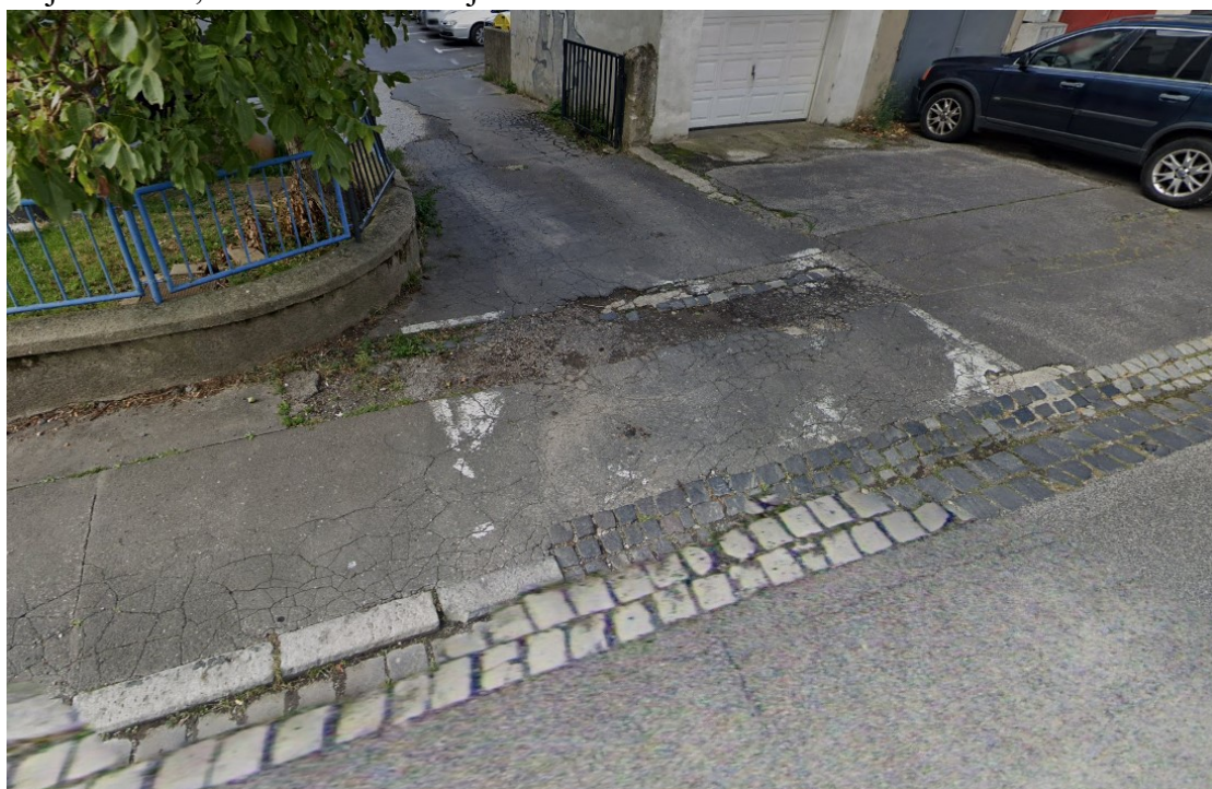
16. Vajnorská 69,79 – asfaltovanie vjazdov
