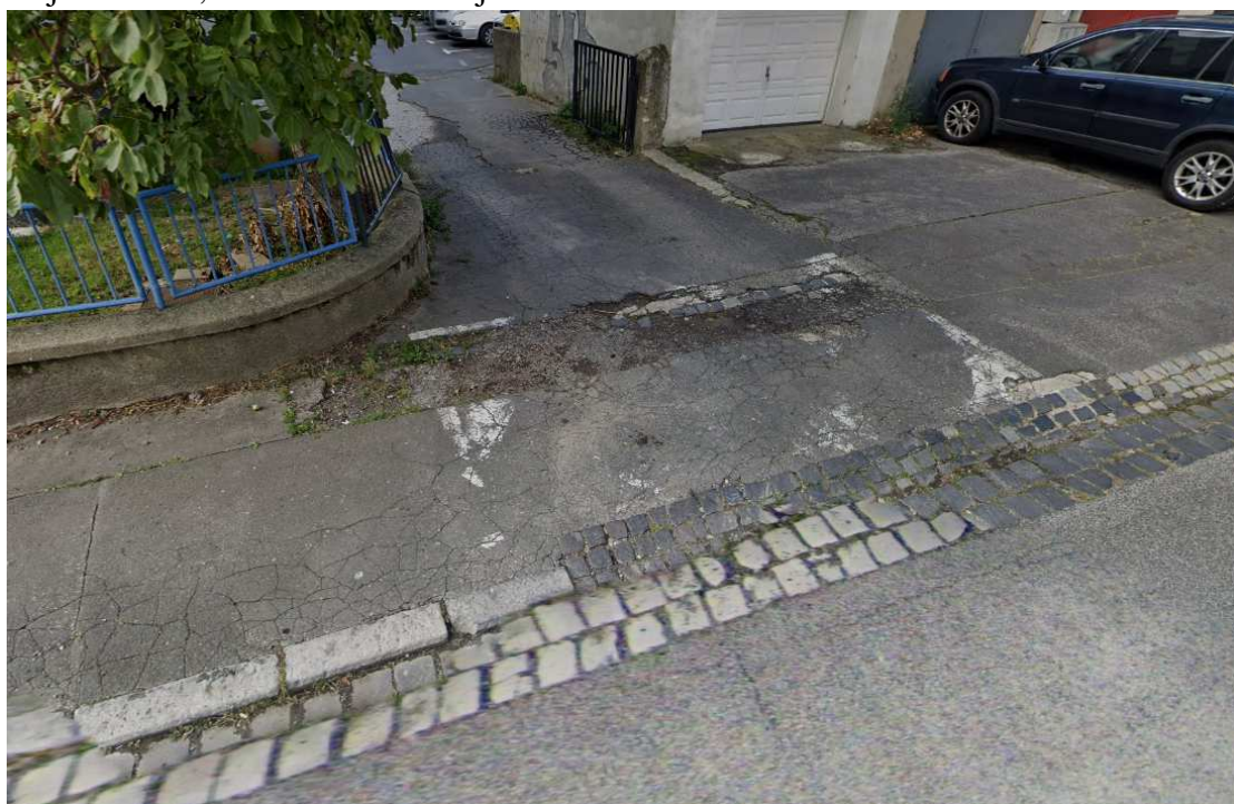
16. Vajnorská 69,79 – asfaltovanie vjazdov
