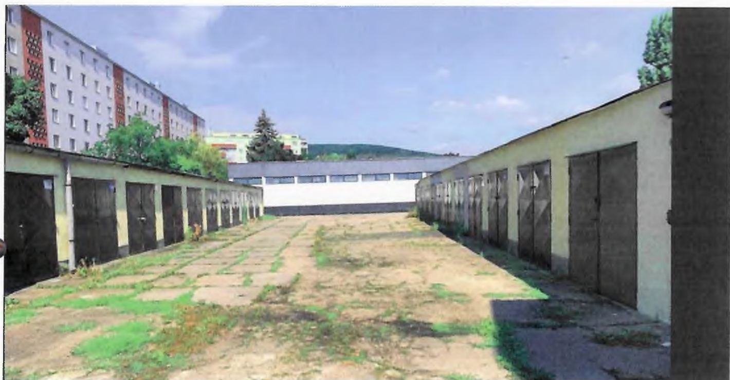
Pohľad od parcely č.12724/40, manipulačná plocha medzi radovými garážami
