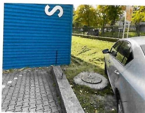
Kanalizačná šachta S2
