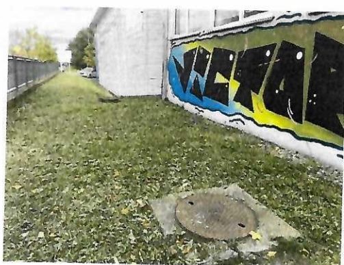
Kanalizačná šachta S1
