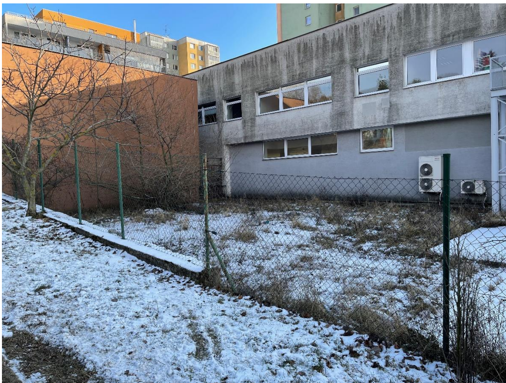
Budova teplárne „Klenová“ a stavby žiadateľa, pohľad zo strany Vlárskej /predmet nájmu – pozemok za plotom/
