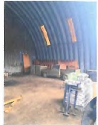
Garáž s.č. 1102, na p.č. 12781_268
