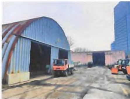
Garáž s.č. 1102, na p.č. 12781_268
