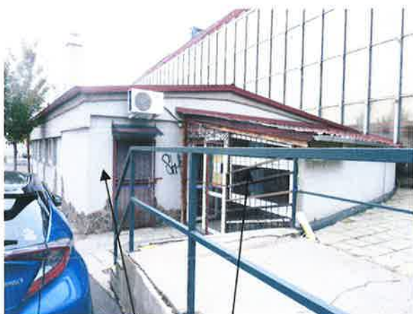
Pohľad SZ na stavbu a prístavbu
