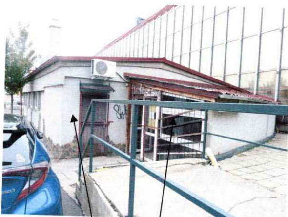
Pohľad SZ na stavbu a prístavbu
