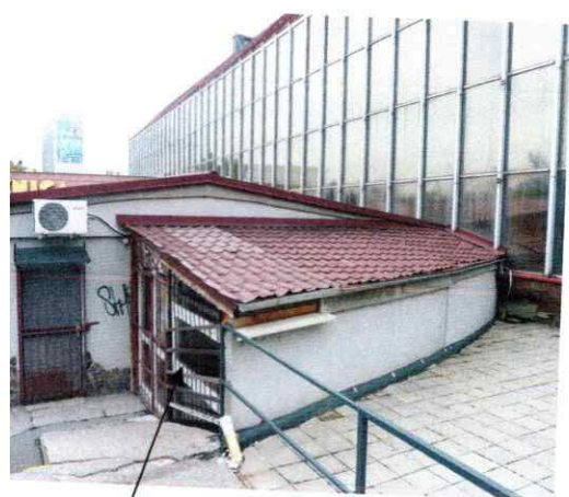
na prístavbu skladu
