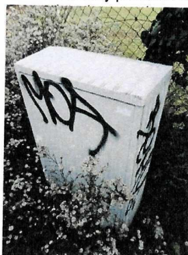
Pohľad na zariadenie UPC, pri oplotení od strany ulice
