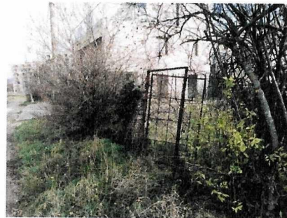
Pohľad v smere od JZ na oplotenie pozemku pri ulici so vstupnou bráničkou
