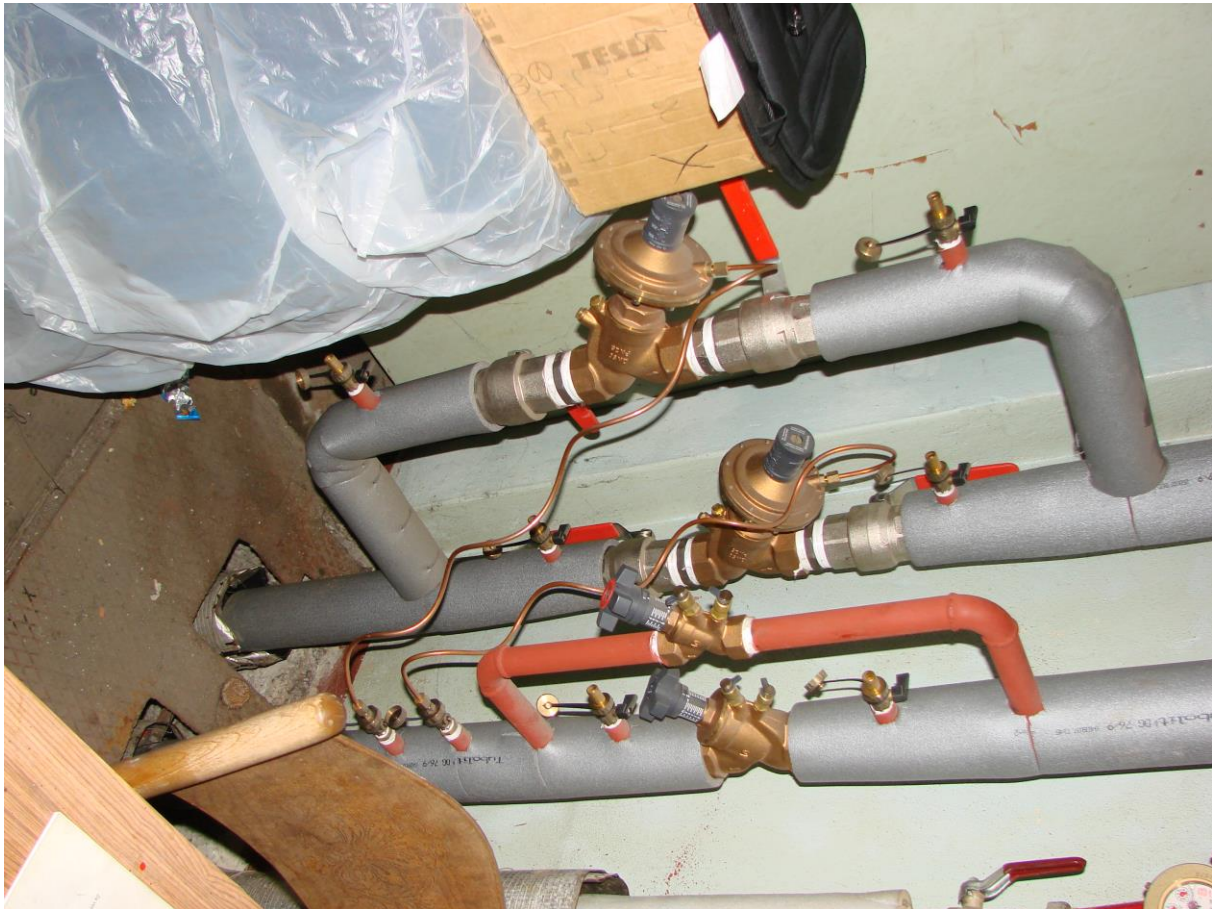
Pohľad na hydraulicky vyregulovaný systém tepelnej siete.
