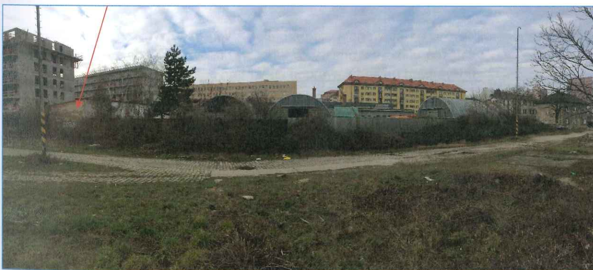
Rozvinutý pohľad z dopravného koridoru pôvodnej železničnej filiálky, depa – foto z p.č. 21283/2. Vľavo budova určená na odstránenie.
