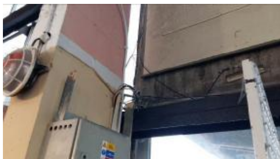
Obr.42 – Nekoncepčne dopĺňaná kabeláž bez ddokumentovania
